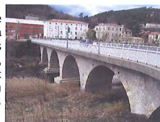
Vue du pont de l'Atelier et l'échelle limnimétrique (source: BRLi)
