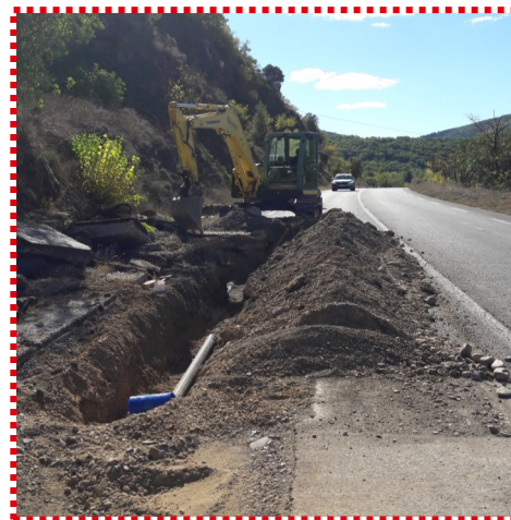
Changement de canalisations d'eau potable à Revêty
