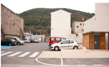
Toilettes publiques place de la Cèze
